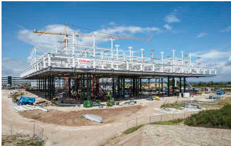
Hydraulischer Hub auf h = 12,5 m, Hubgewicht Stahl + Beton 12.200 t. Hydraulic lift to 12.5 meters, Lifting weight of steel and concrete: 12.200 t.
