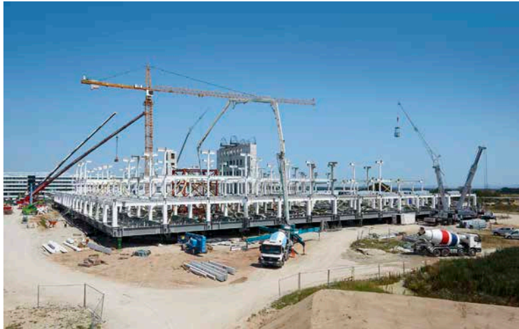
Vormontage auf h = 2 m. Preinstallation on a height of two meters.
