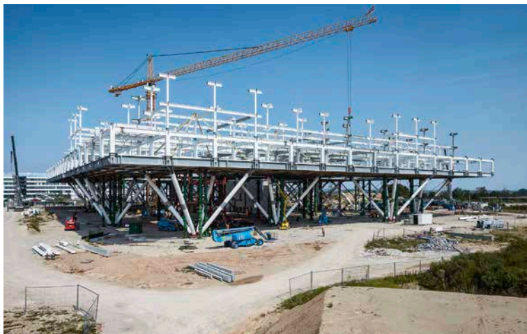
Einbau der V-förmigen Stahlverbundstützen vor dem Absetzen. Installation of the v-shaped steel and concrete supports before lowering.
